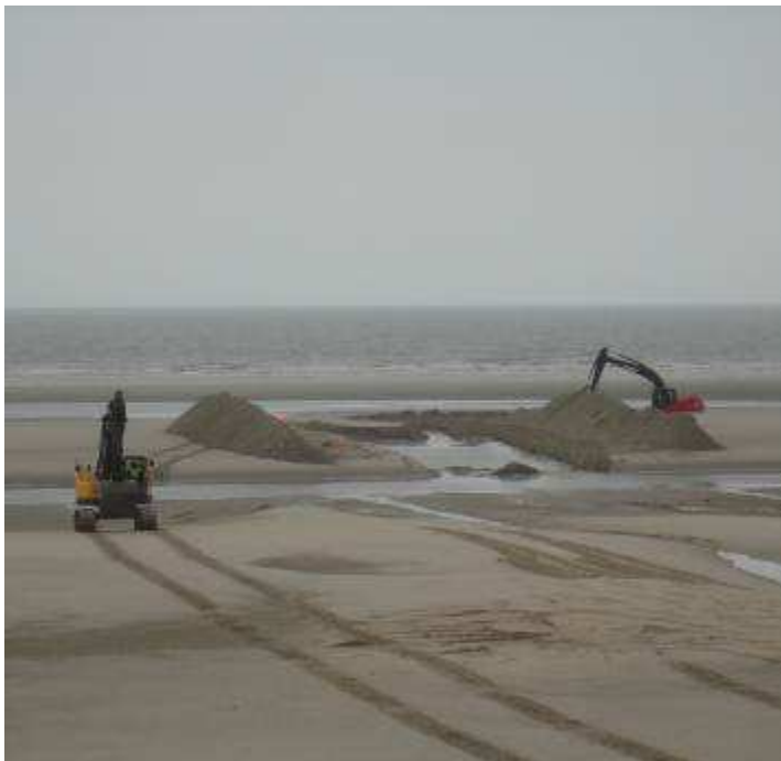
Installation d'un système de drainage de plage à Merlimont pour lutter contre l'érosion (Egis, 2014)
