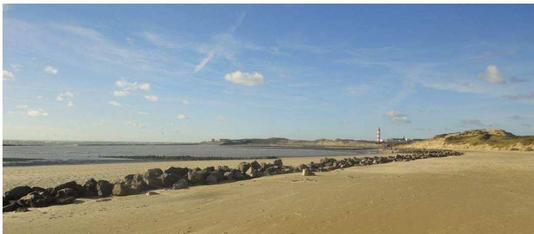
Figure 26 : Anse des Sternes et Pointe du Haut-Banc au fond – cette photo illustre le recul du cordon dunaire derrière le cordon d’enrochements (Egis, Novembre 2013)
