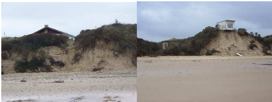
Figure 44 : Habitation en arrière et chalet en surplomb du cordon dunaire du Châtelet à Tardinghen à la suite de la tempête Xaver (DDTM 62, 2013)
