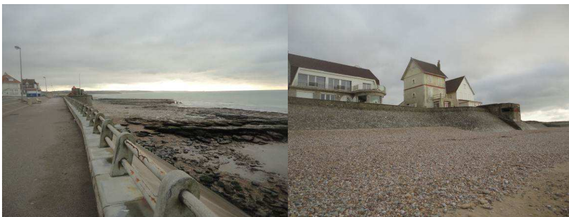
Figure 39 : Platier rocheux devant la digue d'Ambleteuse (gauche) et accumulation de galets en haut de plage à Audresselles (droite) (Egis, Decembre, 2013)
