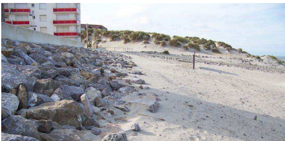
Figure 36 : Front de mer de Sainte Cécile-Plage au niveau du centre de secours et de la rampe –on distingue l'immeuble situé directement en front de mer (DDTM 62, 2013)
