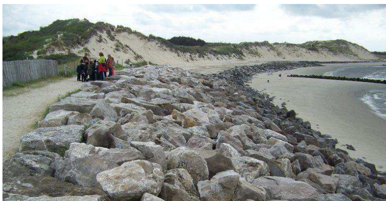
Figure 25 : Digue en enrochements au niveau du Camping du Halloy et cordon d'enrochements existant en arrière-plan (DDTM 62, 2013)
