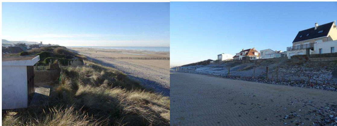
Figure 48 : Habitations et chalet, en surplomb de la dune, protégés par la digue de Sangatte (Egis, Hiver 2013-2014)
