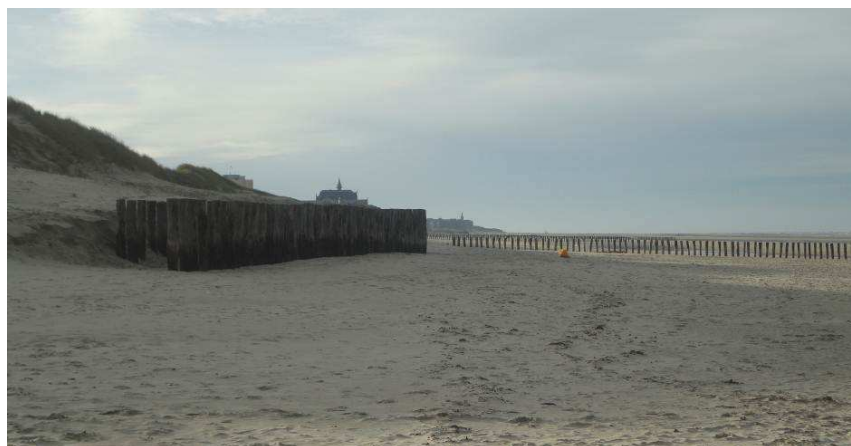
Figure 30 : Epis et brise-lames expérimentaux au Nord de Berck (Egis, Novembre 2013)
