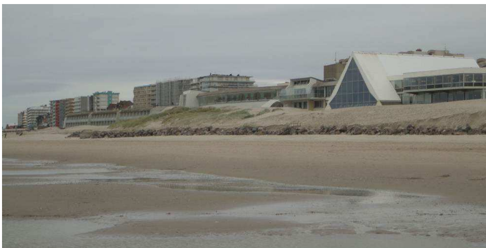
Figure 29 : Centre de thalassothérapie du Touquet protégé par un cordon dunaire et un cordon d'enrochements (Egis, Novembre 2013)
