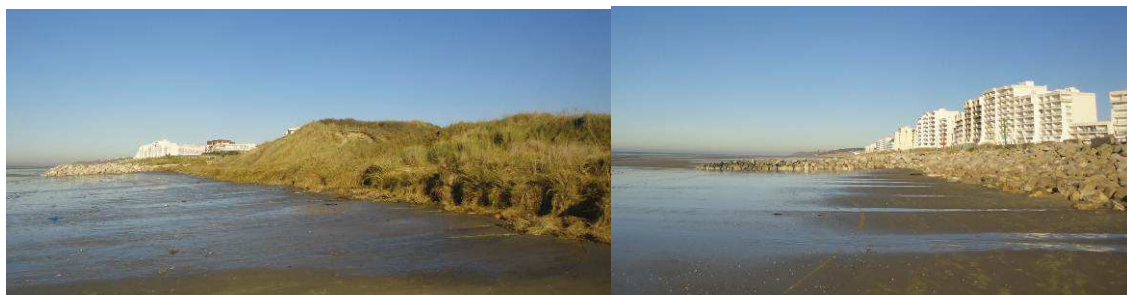
Figure 34 : Résurgence de la nappe phréatique devant la digue en enrochements et au sud d'Hardelot-Plage (Egis, Décembre 2013)
